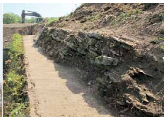
III. 120. Vaade kagukurtiini taaniaegsele eskarpmüürile idabastioni suunast enne taastamistöde algust 2011. aastal. Tegu on ligikaudu 60-kraadise kaldega vastu pinnast laotud õhukese, paari kivirea paksuse paekivimüüriga, mida rootslased ei jõudnud Põhjasõja puhkedes ümber ehitada. Foto: T. Sepp
