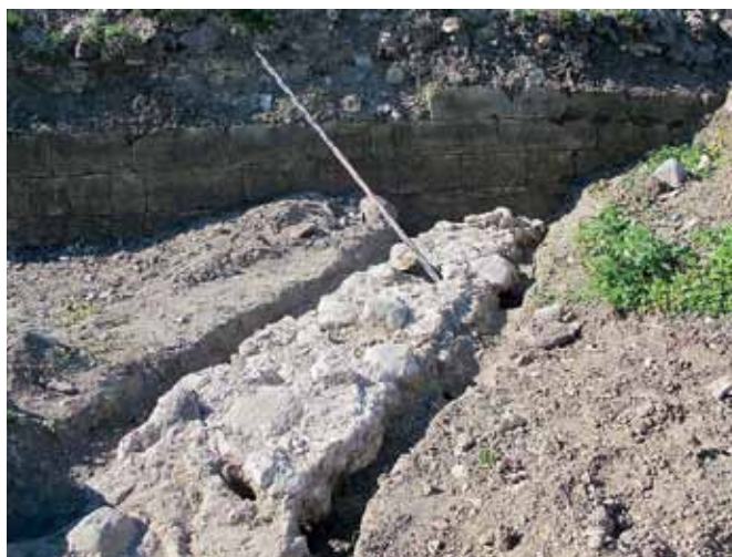
III. 119. Taaniaegse bastioni parempoolse fassi eskarpmüüri lõik läänebastioni põhjaflangil. Väljapuhastatud müüriilõigus tulid nähtavale kuus diagonaalset kanalit tormijooksu takistavate palkide sissemüürimiseks. Mõõtelatt on fotol asetatud ühte neist postiaukudest. Foto: G. Püüa
