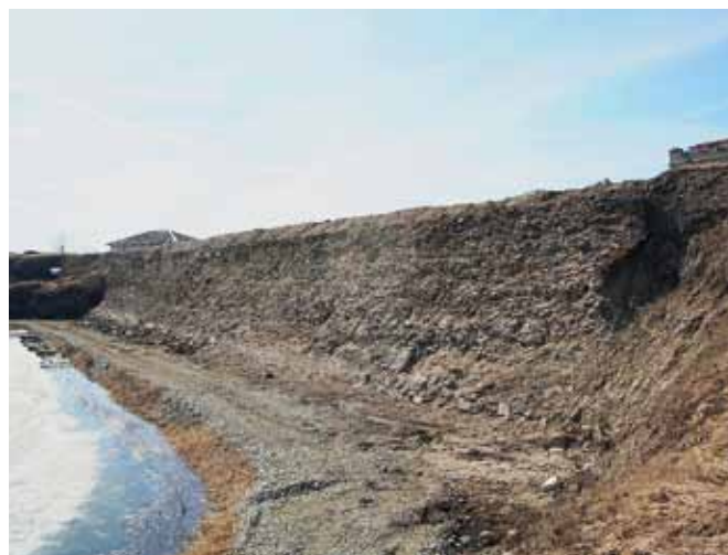
III. 120. Vaade kagukurtiini taaniaegsele eskarpmüürile idabastioni suunast enne taastamistöde algust 2011. aastal. Tegu on ligikaudu 60-kraadise kaldega vastu pinnast laotud õhukese, paari kivirea paksuse paekivimüüriga, mida rootslased ei jõudnud Põhjasõja puhkedes ümber ehitada. Foto: T. Sepp
